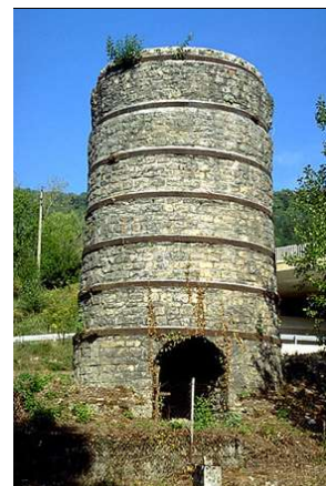
Four à chaux (Jura)
