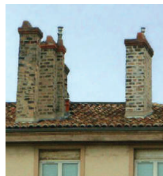
Souches de cheminées
